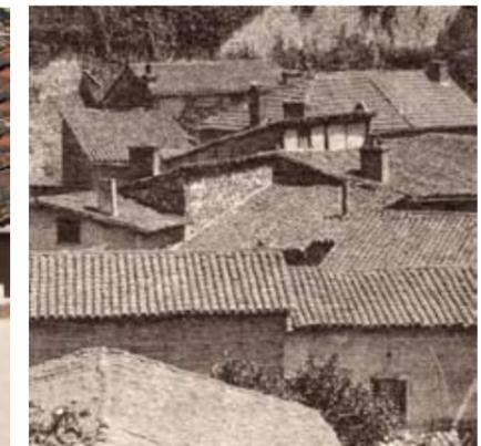
Les toitures sont massivement de tuiles canal, pratiquement remplacées aujourd'hui à 90% par des tuiles mécaniques grand moule, ou toutes sortes de matériaux, au point que les finitions traditionnelles ont disparu.
