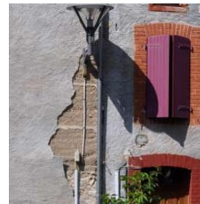
C'est en général la dégradation de l'enduit qui fait réapparaître le pisé...
