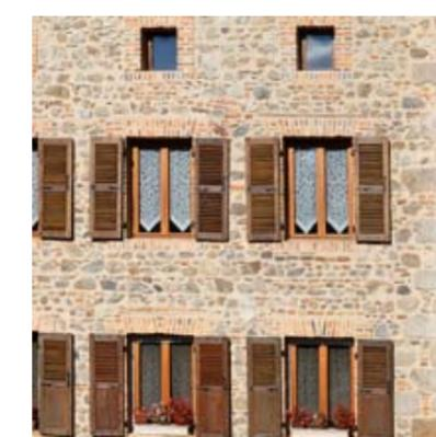
L'analyse des maçonneries visibles montre bien qu'elles sont constituées d'éléments disparates, non destinés à rester vus (même s'ils sont réapparés). Les maçonneries modernes sont les plus négligées, avec d'improbables mélanges de pierre de récupération, de briques diverses et même de planches en bois assurant les arcs de décharge.
