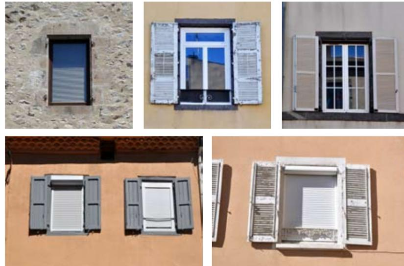
Toujours sous couvert d'isolation thermique, les menuiseries sont souvent "simplifiées" ou dessinées de manière inélégante, ce qui peut conduire à altérer l'architecture. C'est en général une conséquence de l'utilisation de châssis en métal ou en matière plastique. De même, l'irruption de volets roulants dénature l'architecture traditionnelle. Les règles de l'AVAP peuvent s'opposer à ces dérives. (exemples négatifs dans le Cantal, la Haute-Loire, le Puy de Dôme).
