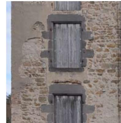
En se dégradant, les enduits font réapparaître la maçonnerie de base. On croit à tort qu'il s'agit d'une sorte d'état des origines qu'on gagnerait à révéler. En fait, on fait surtout disparaître toute possibilité de mise en valeur des dispositions architecturales : régularités, symétries, décor.
