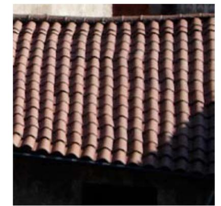
La tuile canal permet, si on "déforme" les rangées de compenser des irrégularités du plan. De même on peut la faire "serrer" (avec une légère incurvation) ce qui améliore l'étanchéité.
