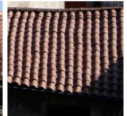
Véritable tuile canal (Haute-Loire et Châteldon). La tuile canal permet des déformations, qui rendent la toiture d'un aspect plus vivant.
