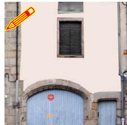
Dans le premier cas, la solution est un enduit de qualité, qui permettra de mettre en valeur les éléments en pierre du rez de chaussée, dans l'autre une mise en couleur adaptée à la période Art-déco de la façade.
