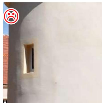
Un enduit trop fin peut aussi se révéler inadapté, en gommant de manière trop sensible les irrégularités de la maçonnerie (Allier).
