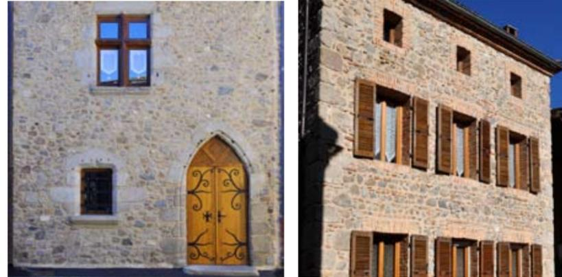
Une tendance perdue à Châteldon : celle qui consiste à décrépiter entièrement les maçonneries en supprimant l'enduit pour faire "ré-apparaître" la pierre. Il s'agit le plus souvent de moellons et d'appareillages peu élaborés, combinés parfois avec de la terre cuite et des morceaux de bois... On perd la lisibilité de l'architecture.
