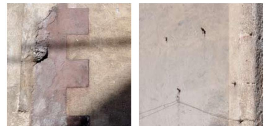
Enduits et décors simples de Châteldon (relevés en 2014 ou documentation figurée). À gauche décor dit "en harpe" à droite, chaîne d'angle simulée droite.
