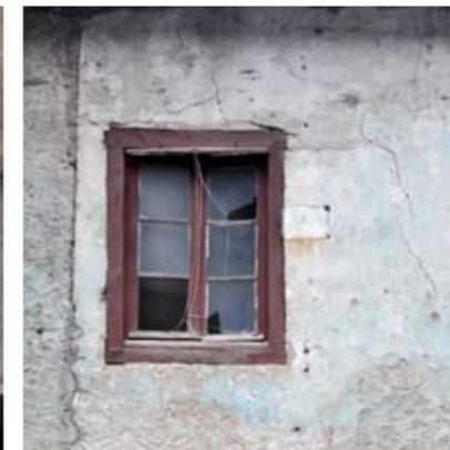
Enduits anciens relevés en 2014 à Châteldon. On voit que même les constructions les plus modestes sont enduites, et les pierres recouvertes (y compris les chaînes d'angle).
