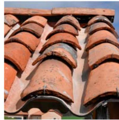
La pose de tuiles canal sur forme ondulée a souffert d'une expérimentation locale qu'on peut juger peu convaincante. Il s'agit pourtant d'un procédé de substitution intéressant, qui pourrait être développé.
