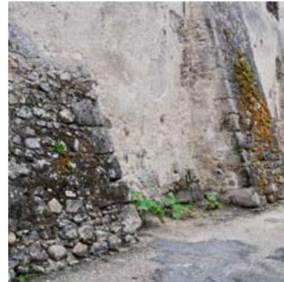
Une erreur fréquente, concernant les maçonneries vétustes : l'enduit s'est désagrégé et les moellons réapparaissent. Cet aspect érodé conduit souvent à vouloir décrépiter entièrement des façades.
