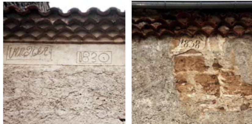
Enduits datés en milieu rural (Haute-Loire, Limagne). Ces exemples nous renseignent sur les textures d'enduit à mettre en œuvre sur ce type de construction.-
