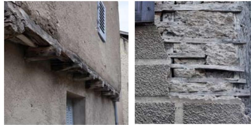
Deux indices de la présence d'une structure en pan de bois : un encorbellement, et l'existence d'un enduit sur lattis.
