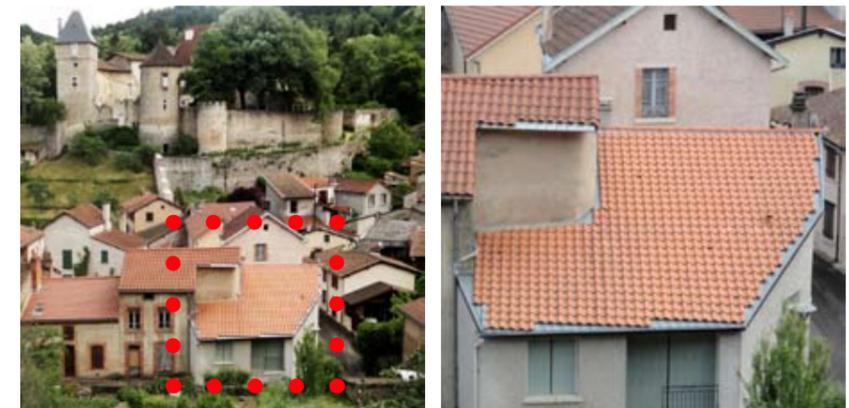
Un cas type : un immeuble moderne, en co-visibilité directe avec le château. Il relèverait, selon sa typologie, de la tuile mécanique grand moule (comme ses voisins). Il a été recouvert en tuile romane (d'ondulation faible et régulière, d'un dessin peu adapté), ce qui a nécessité (comme si on avait employé de la mécanique classique) un recours important à la zinguerie.
