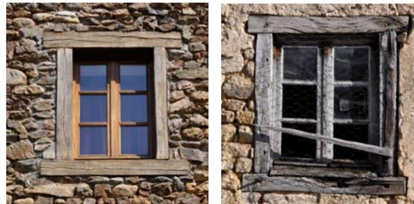
Dans le contexte local, on peut aussi mettre en œuvre des ouvertures à encadrements bois, fréquentes en Livradois-Forez. Dégradées, elles ont souvent été remplacées dans les années 1880-1900 par des fenêtres à encadrement brique. (Puy de Dôme, Rongère-Montagne)
