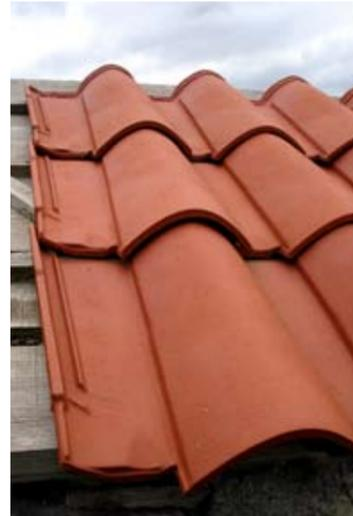
Une tuile romane acceptable devra présenter une onde forte qui l'assimile visuellement à la tuile canal traditionnelle, et un couvert incurvé de forme trapézoïdale (et non rectangulaire).
