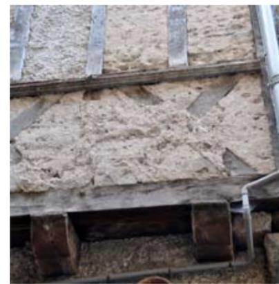
Si dans la pratique un pan de bois est enduit (pour protéger le remplissage), lorsqu'on le dégage, et qu'on ré-enduit le remplissage, il se forme un bourrelet inesthétique et techniquement douteux (effet de coussinet). Ce type d'aspect doit être évité. (à gauche, pan de bois enduit, Tarn).
