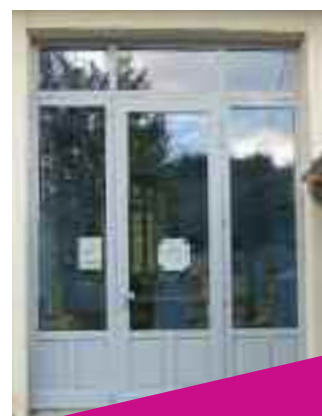
La porte vitrée de l'école maternelle a été remplacée pour un coût de 4 603 € HT.
