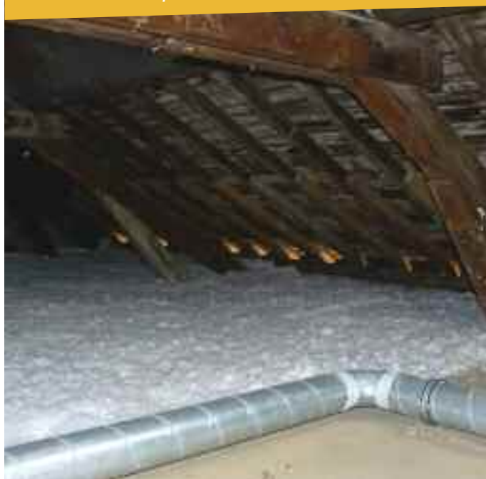
Isolation de combles perdus
